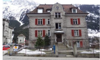
Mehrfamilienhaus Gotthardstrasse 6487 Wassen
