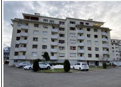
4-Zimmerwohnung Luzernerstrasse 6440 Brunnen
