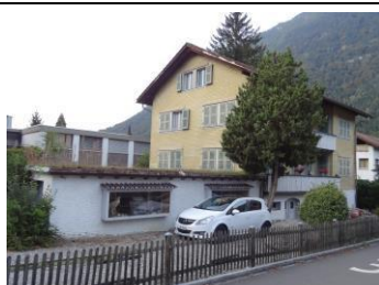
Mehrfamilienhaus Besslerweg 6460 Altdorf
