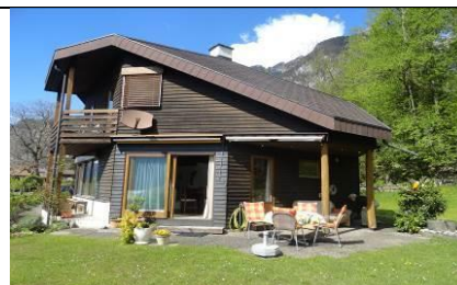
Einfamilienhaus Höhenstrasse 6454 Flüelen
