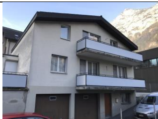
Mehrfamilienhaus Lindenstrasse 6472 Erstfeld
