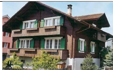
Einfamilienhaus Blumenfeldgasse 6460 Altdorf
