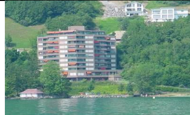
Div. Wohnungen Gersauerstrasse (Schiller) 6440 Brunnen
