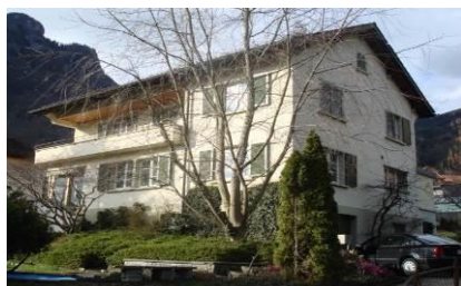
Einfamilienhaus Stückistrasse 6442 Gersau
