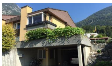
Doppeleinfamilienhaus Höhenweg 6454 Flüelen
