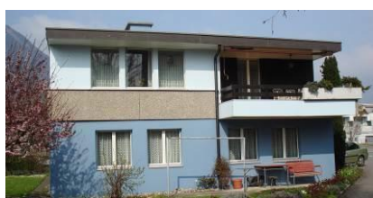
Einfamilienhaus Sportplatzweg 6440 Brunnen
