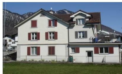
Mehrfamilienhaus Schwyzerstrasse 6440 Brunnen
