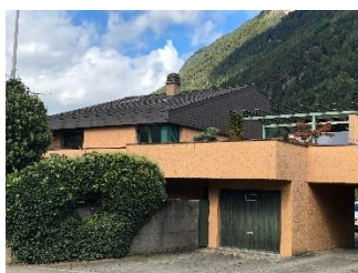
REFH Klausenstrasse 6460 Altdorf
