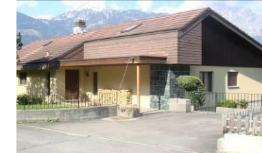
Einfamilienhaus Bustistrasse 6467 Schattdorf
