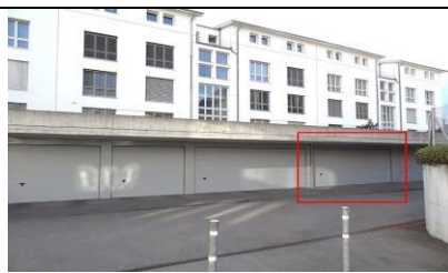
Doppelgarage Bahnhofplatz 6440 Brunnen
