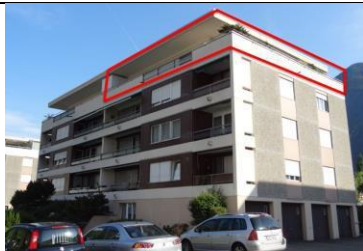
4 ½-Zimmer-Attikawohnung Baumgärtli 6467 Schattdorf
