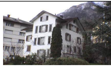
Mehrfamilienhaus Dorfstrasse 6452 Sisikon
