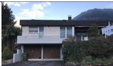
Einfamilienhaus Bäregand 6467 Schattdorf
