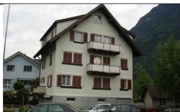
Mehrfamilienhaus Seedorferstrasse 6460 Altdorf
