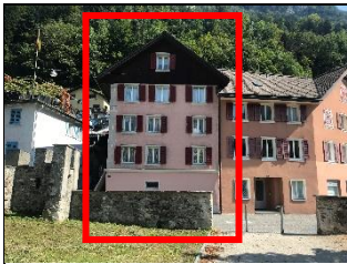
Zweifamilienhaus Dorfstrasse 6454 Flüelen
