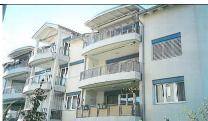
Mehrfamilienhaus Feldmatte 6206 Neuenkirch
