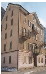
MFH Gotthardstrasse 6472 Erstfeld
