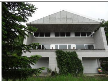
Einfamilienhaus Bustistrasse 6467 Schattdorf
