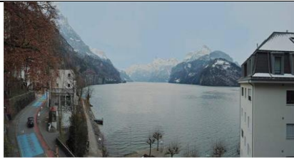
Diverse Wohnungen Projekt Parking 6440 Brunnen
