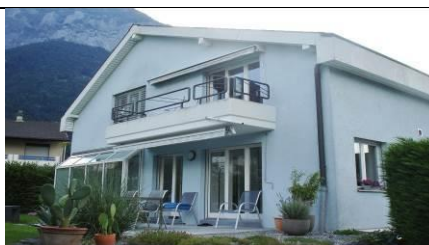
Einfamilienhaus Blumenfeldstrasse 6462 Seedorf
