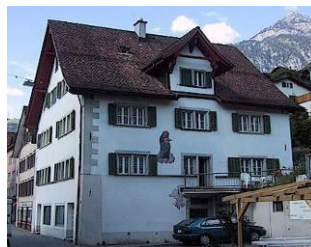
Mehrfamilienhaus Rämi-Haus 6454 Flüelen
