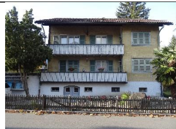
Mehrfamilienhaus Besslerweg, 6460 Altdorf
