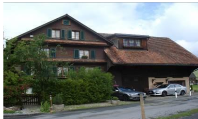
Bauern- / Gadenhaus Wäni 8840 Einsiedeln
